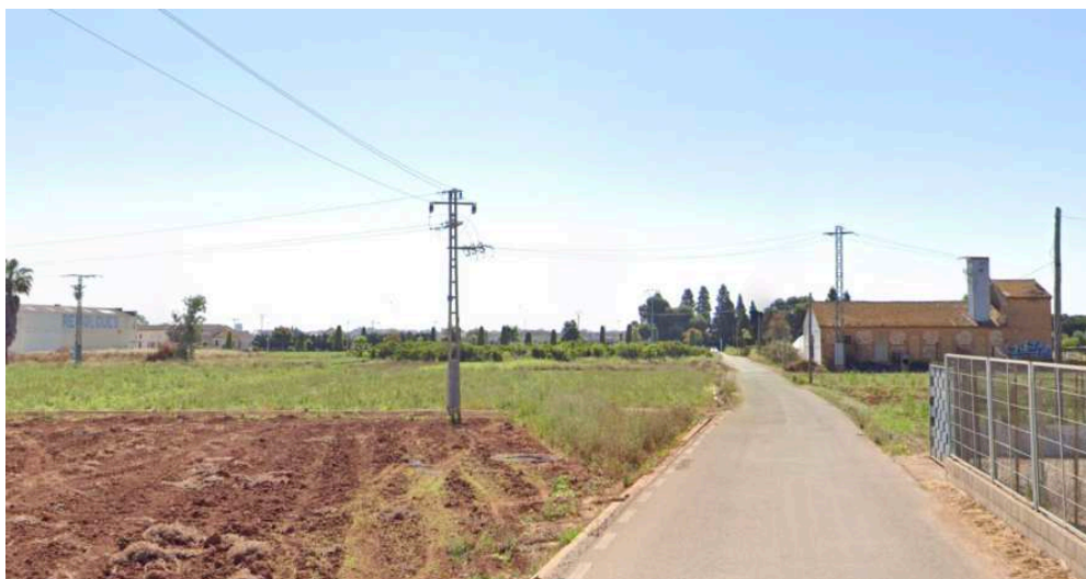
Ilustración 2. Tendidos eléctricos de Media Tensión en el ámbito de actuación
